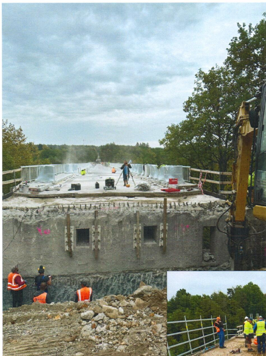
Výstavba nové opěry ze strany od Mirotic
