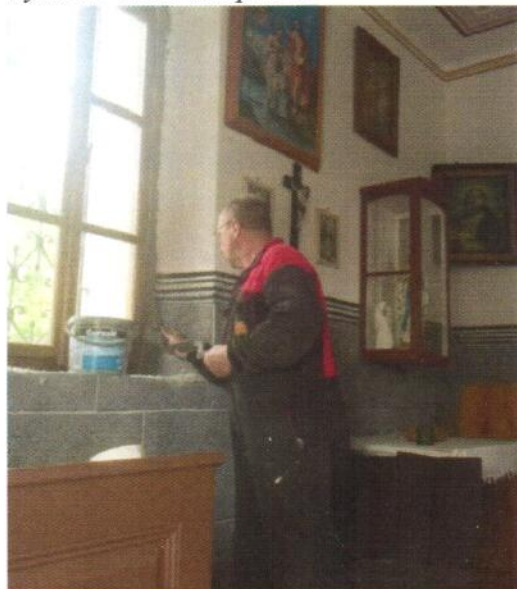
Výměna oken v kapličce
