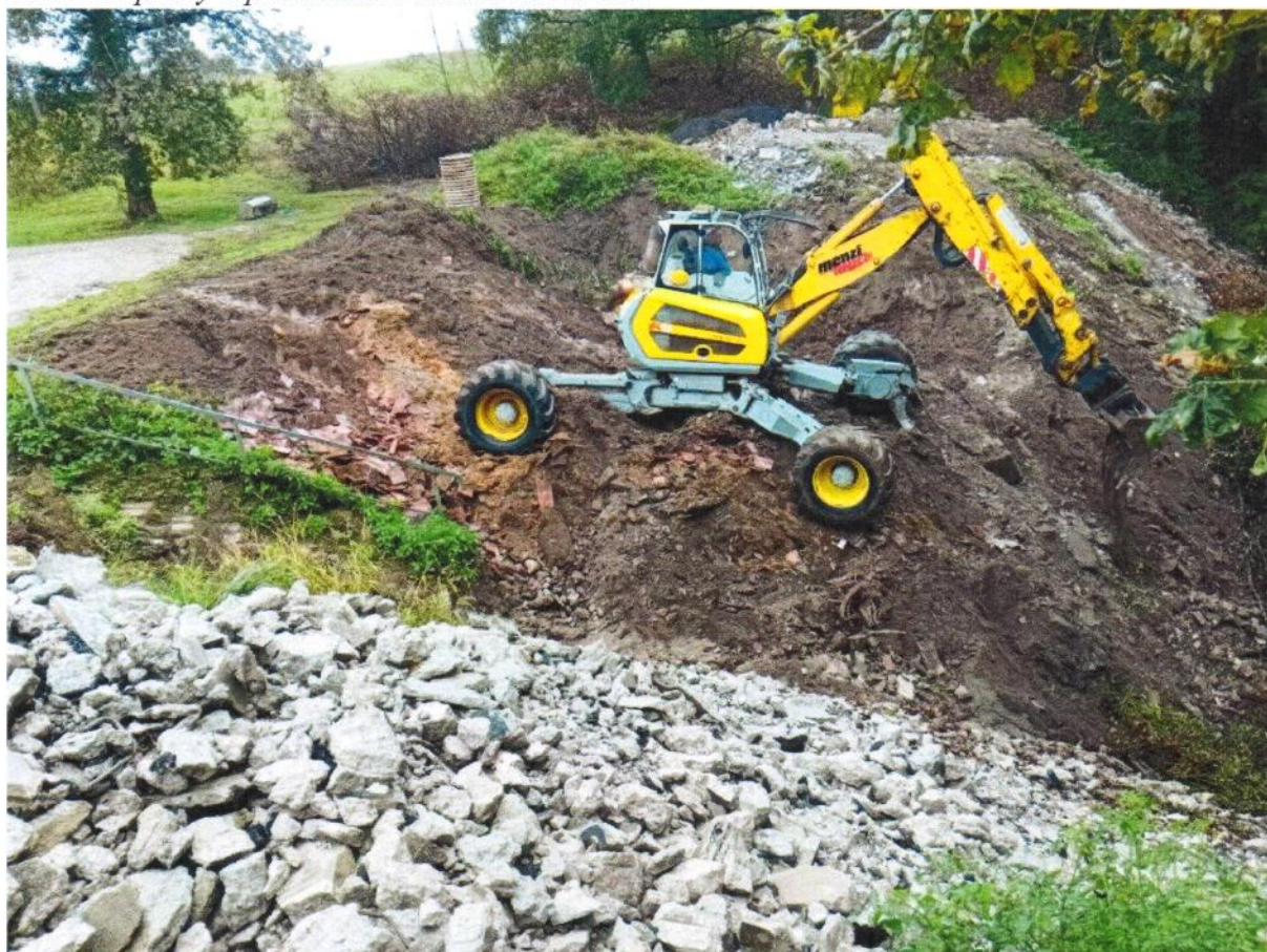
Terénní úpravy a prodloužení kanalizace u ČOV
